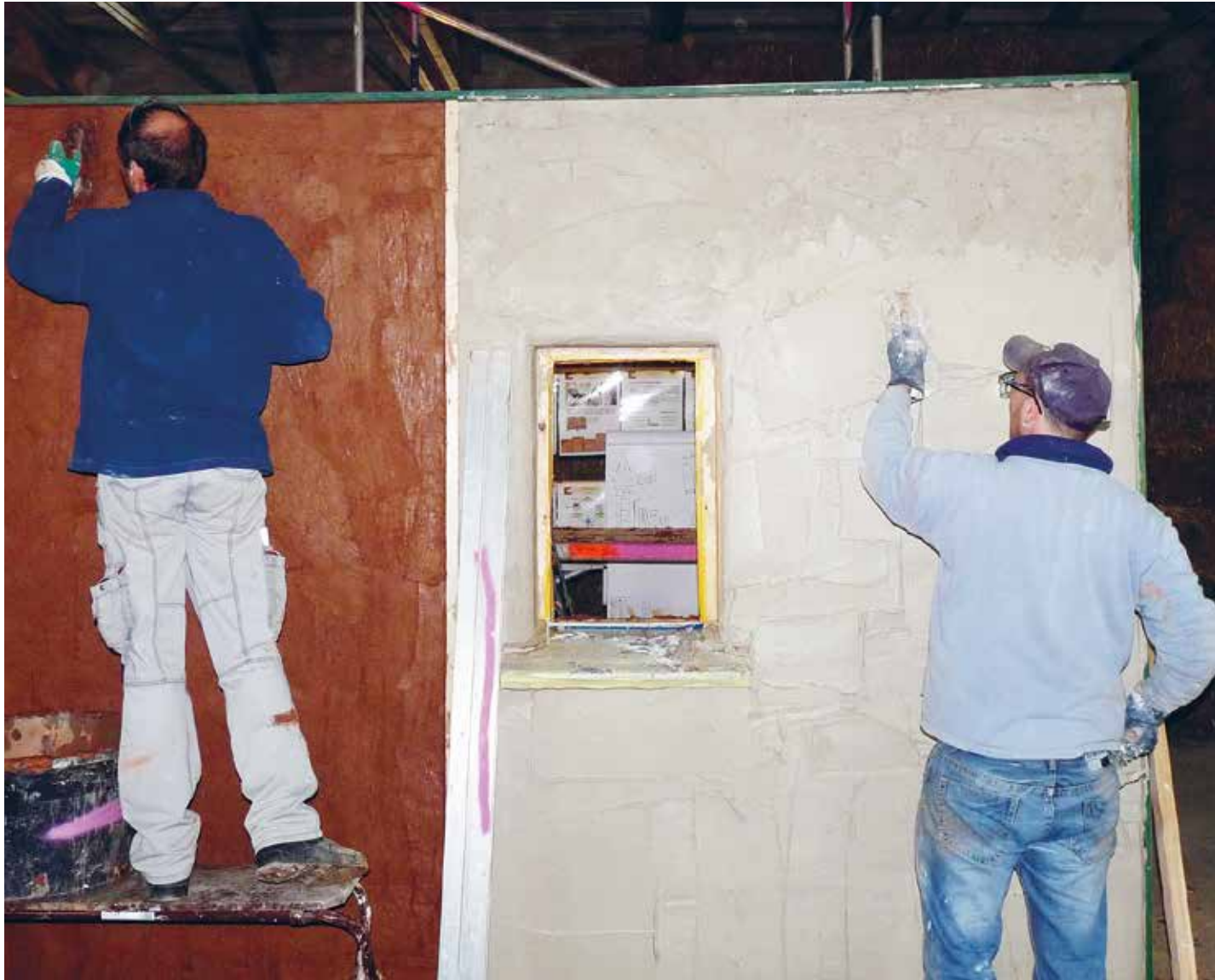
Auch das Verputzen von Wänden aus Strohballen will gelernt sein Foto: Biwena
