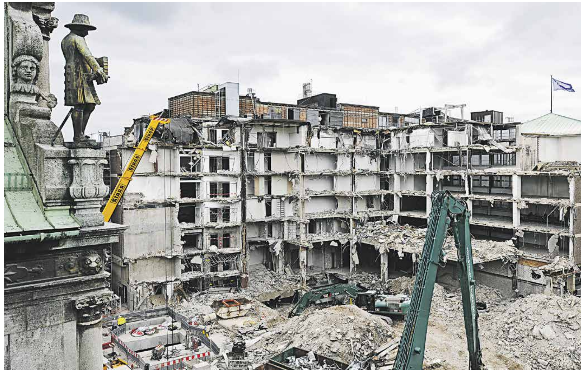
Das Stadtzentrum als Baustofflager: Abriss des ehemaligen Gebäudes der Bremer Landesbank...
