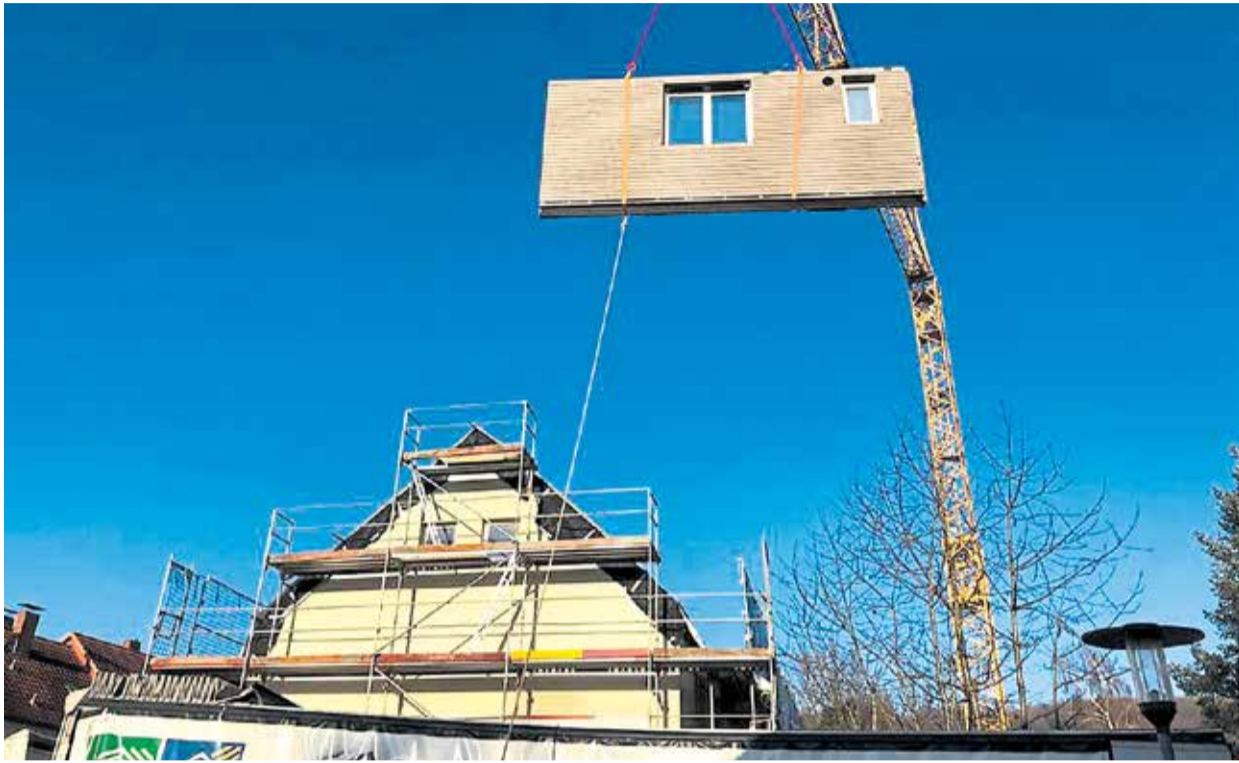
Lieferung der seriell vorgefertigten Fassadenteile: Innerhalb von zehn Tagen waren sie in Hameln montiert Foto: Ecoworks GmbH
